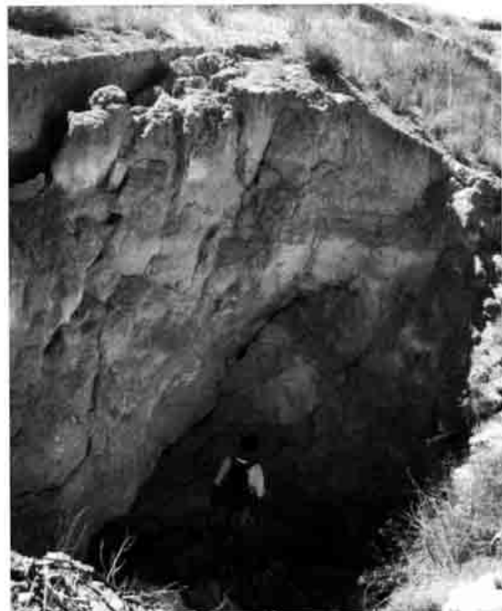
Figura 5. Margen de una dolina de colapso formada junto a una pista. Se observan grietas de descarga y un escalón que evidencian la inestabilidad de esta pared extraplomada.
