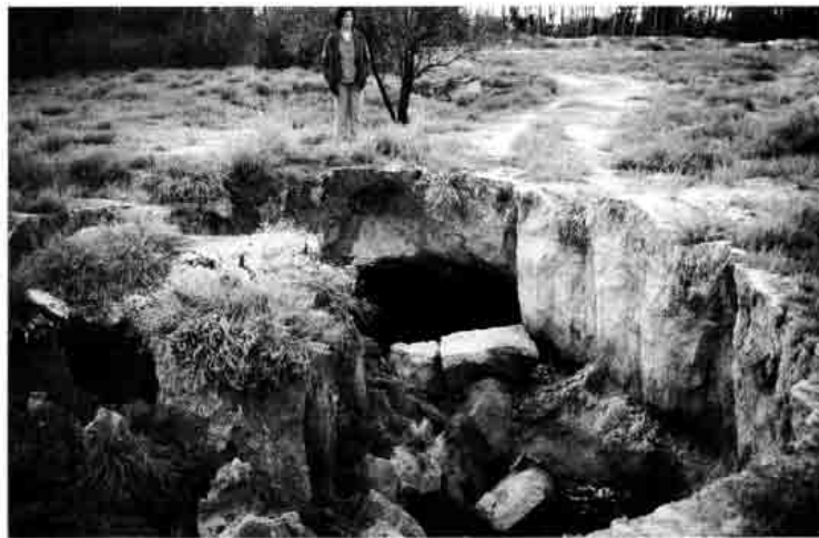
Figura 6. Dolina de colapso que afecta a limos yesíferos y al substrato evaporítico, originada tras la tormenta del 15/10/99.
