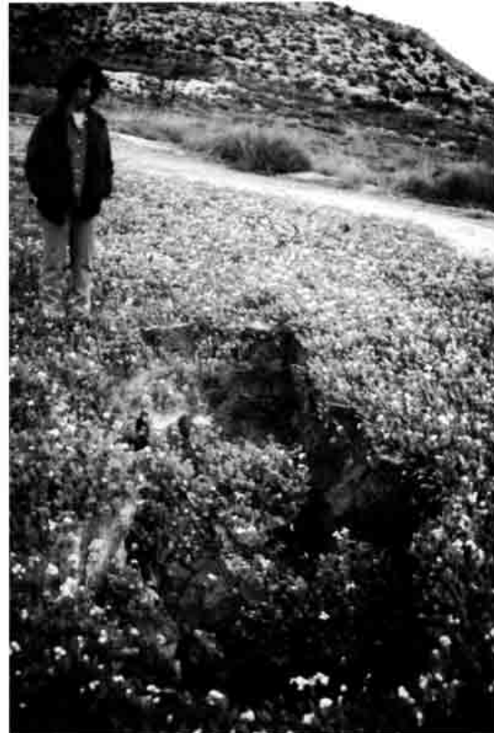
Figura 7: Dolina de colapso alargada en dirección de la fracturación dominante y generada como consecuencia de la tormenta del 15/10/99.
