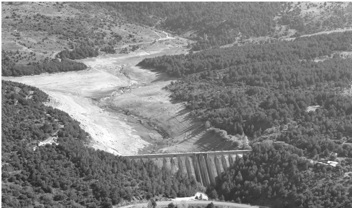
Figura 4. Vista aérea oblicua de la presa de Puente Alta, así como de su cuenca vertiente, al inicio de las obras de impermeabilización del paramento durante el verano de 1995 (en Rodríguez, 1996)
