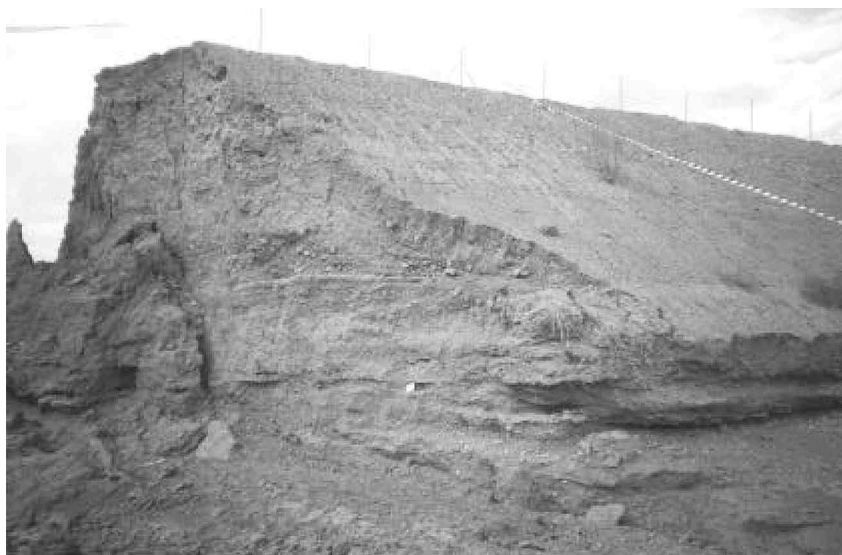
Figura 2. Corte esquemático y visión de los materiales el dique de la balsa en la brecha Figure 2. Schematic diagram and general view of materials in the inner part of dam break
