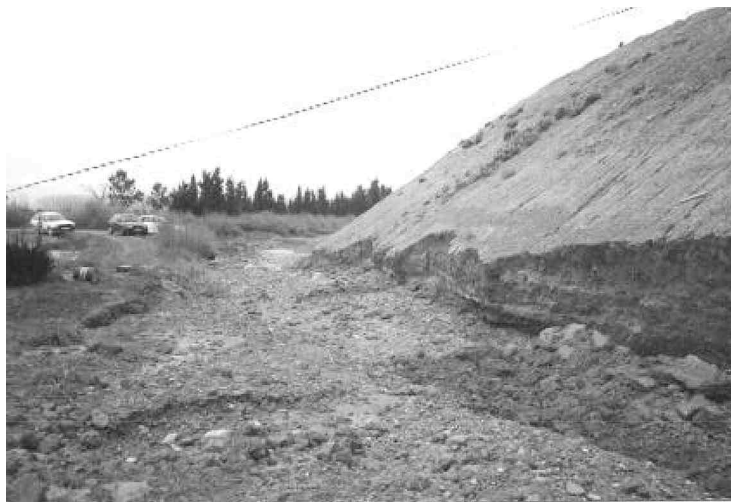
Figura 5. Socavación por flujo concentrado en la base del talud de la balsa Figure 5. Rill erosion at the dam-basement
