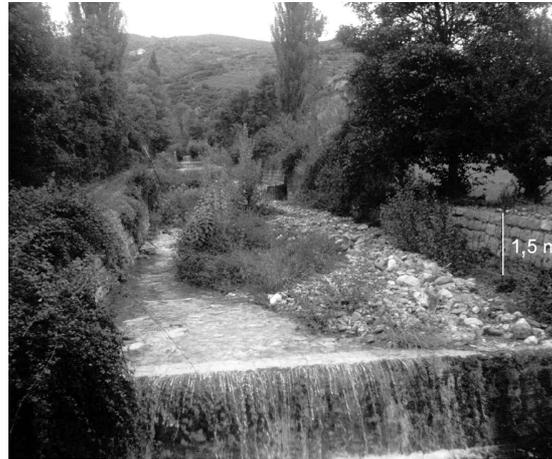
Figura 5. Vista del tramo canalizado donde se observa el relleno parcial de sedimentos y la vegetación que lo ha colonizado.
