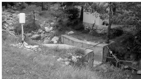
Figura 2. Fotografía de la estación de aforo de Ca L'Isard. Figure 2. Photography of the Ca l'Isard gauging station. (Foto: J. Latron).
