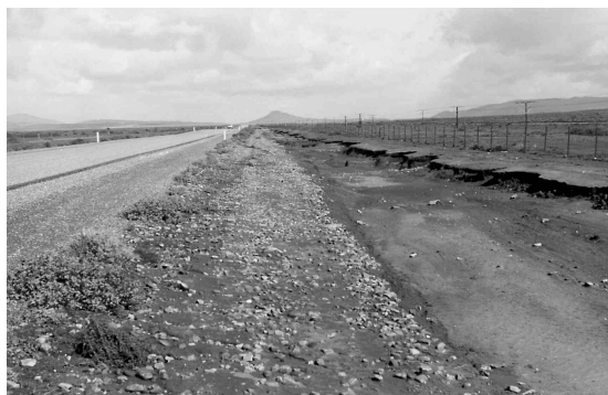
Figure 8. Gullying in roadside area alongside the Quorn-Hawker road sealed in the mid nineteen 'sixties. The gully was soon filled by natural runoff, deposition and vegetational colonisation. Figura 8. Acarcavamiento en una zona adyacente a la carretera a lo largo de la ruta Quorn-Hawler, carretera asfaltada a mediados de los años 1960. El acarcavamiento se selló por la escorrentía natural, por deposición y por colonización vegetal.
