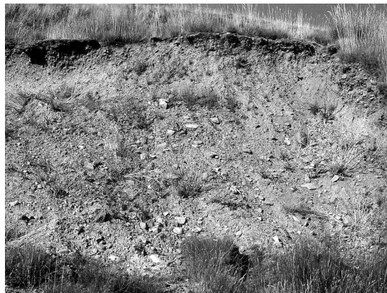
Figura 7. Material afectado por los movimientos de ladera.
