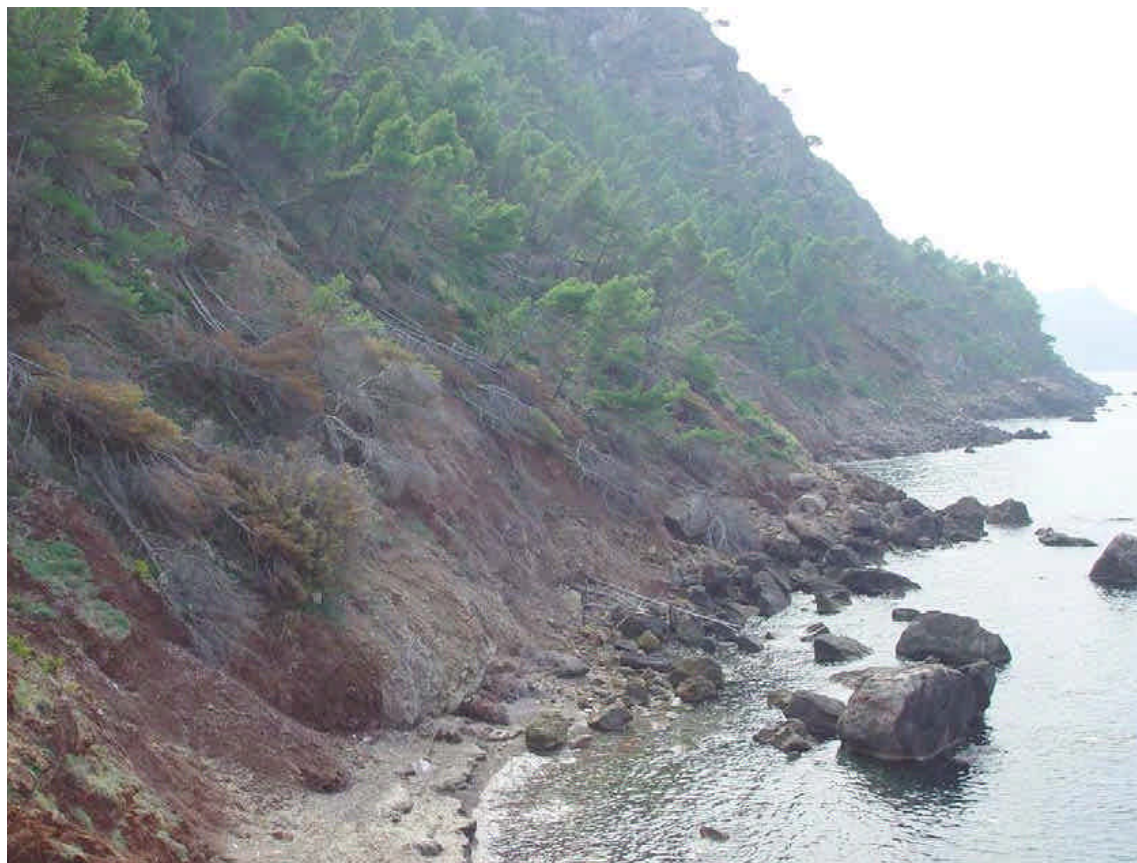
Figura 3. Deslizamientos y desprendimientos en las inmediaciones del puerto de Valldemossa (Mallorca), agravados por los temporales de noviembre 2001
