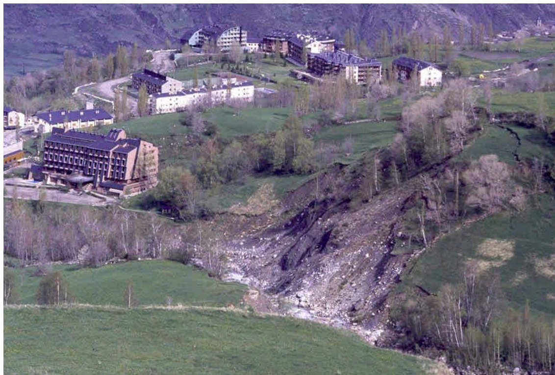
Figura 1. Deslizamiento rotacional en los depósitos glaciares de Cerler (Huesca). La erosión del barranco de Remáscaro es uno de los desencadenantes principales del movimiento.
