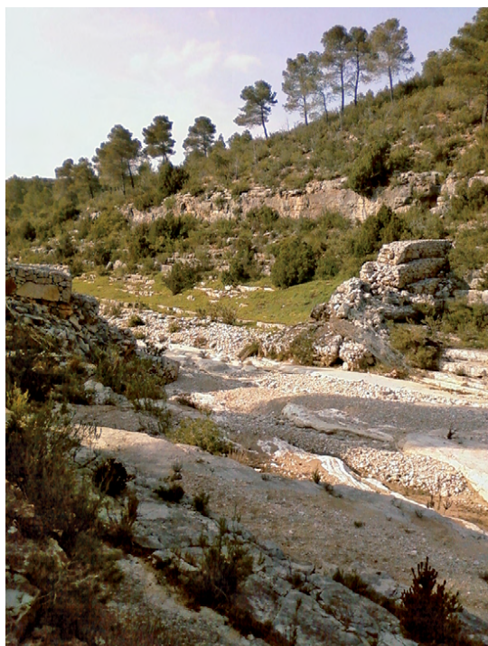
Figura 3. Presa de gaviones destruida por una crecida en la Rambla del Tambuc, situada 1 km aguas arriba del dique cartografiado por Santisteban (2014).
