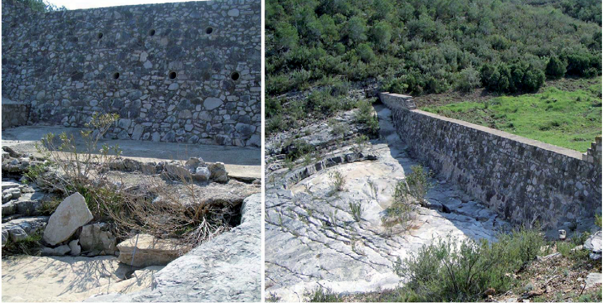
Figura 4. Incisión sobre el sustrato mesozoico causada por dos diques consecutivos de retención de sedimentos situados a poco más de 1 km aguas arriba del área de estudio. La imagen de la derecha corresponde a la presa que Santisteban (2014) sitúa en su figura 2 y que identifica como presa de gaviones, aunque en realidad, como se observa en la imagen, es de mampostería.
