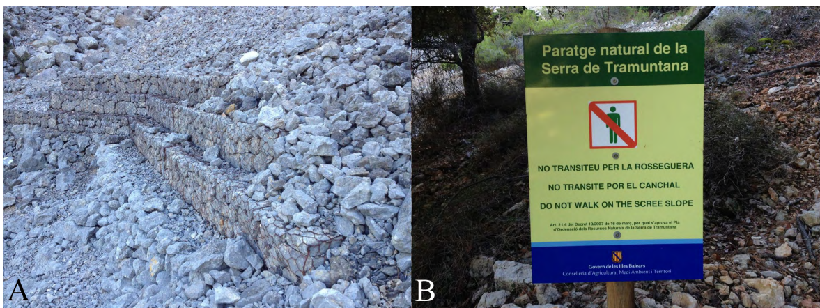
Figura 5. A) Actuación mediante gaviones en el ápice terminal del lóbulo central del canchal de Tormir para evitar la afectación a la embotelladora. B) Cartelería anunciando la prohibición de tránsito sobre el canchal.
