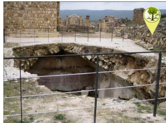
Fig. 20. Aljibe del Castillo que como consecuencia del terremoto desaguó todo el contenido (aprox. 400 m<sup>3</sup>) sin que se hubieran producido grietas evidentes en su vaso. Las características de este efecto nos permiten considerar que se debió producir algún desplazamiento en los materiales infracayentes que produjera la pérdida de impermeabilidad del aljibe.
