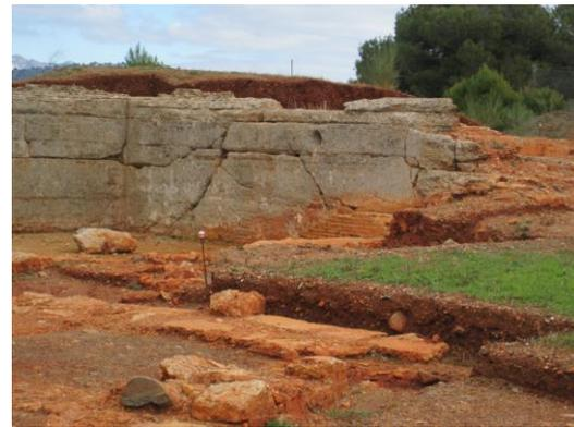
Figura 15. Fracturas conjugadas afectando al alzado oriental de la Alberca Rota del Cerro del Sol.
